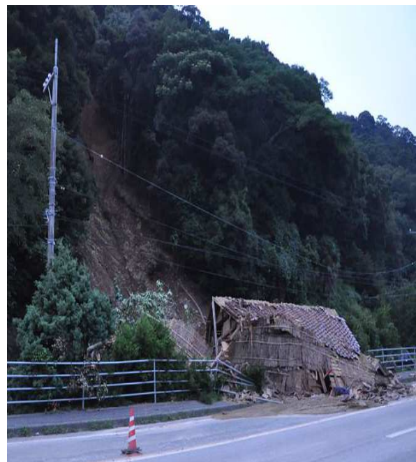
裏山崩落で全壊し国道に押し出された住宅 須佐
