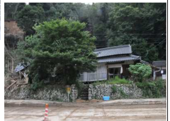
裏山崩落で全壊状態の住宅 須佐
