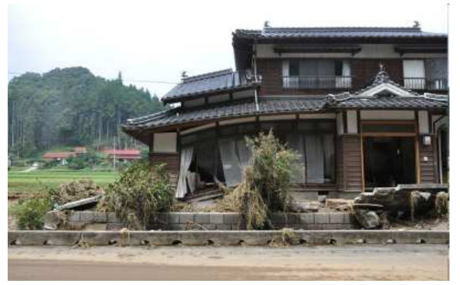
濁流が押し寄せ全壊状態の住宅 小川
