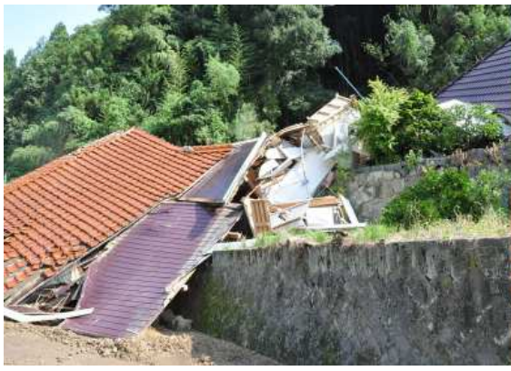
裏山が崩れ倒壊した家屋 小川
